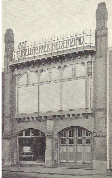
Fabriekspand, Blekerstraat, Groningen
